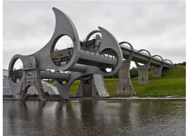
Il s'agit en réalité d'une écluse, ou plus précisément d'un ascenseur à bateaux, située entre Édimbourg et Glasgow. Ouverte en 2002 et unique au monde, elle permet de monter et de descendre par rotation 4 péniches en même temps, à flot dans 250 000 litres d'eau, sur un dénivelé de 35 mètres.
